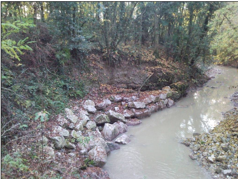
FOTO 18 visibili cedimenti lungo la sponda sinistra a valle del terrapieno di Viale Oriani.
