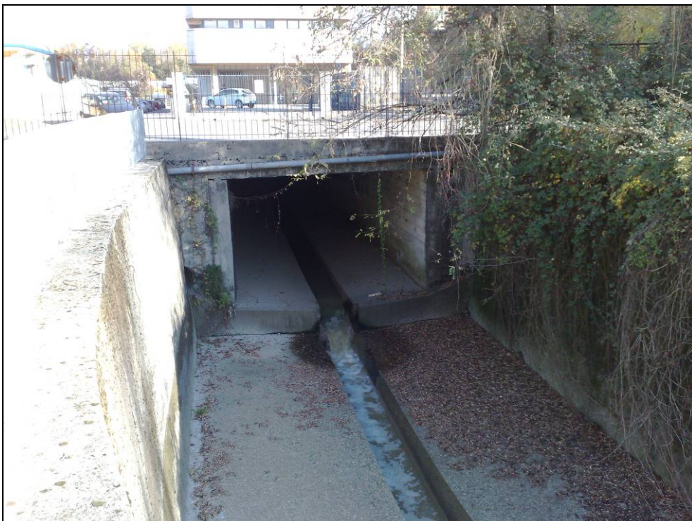
FOTO 54 il torrente Corno fuoriesce dalla copertura dell'area industriale prossima al fiume Isonzo.
