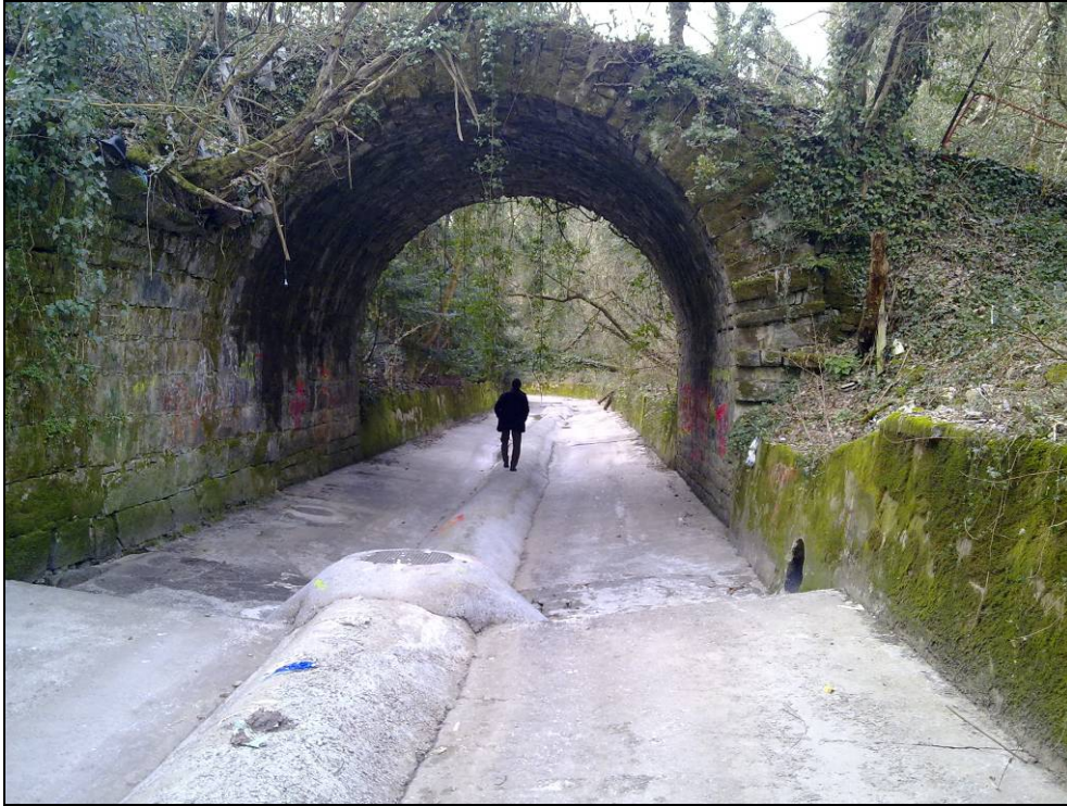
FOTO 13 lo stato di fatto del vecchio ponte in pietra di via del Boschetto all'interno della Valletta.
