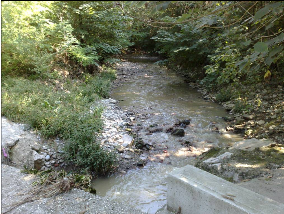
FOTO 21 il torrente Corno a monte del guado.
