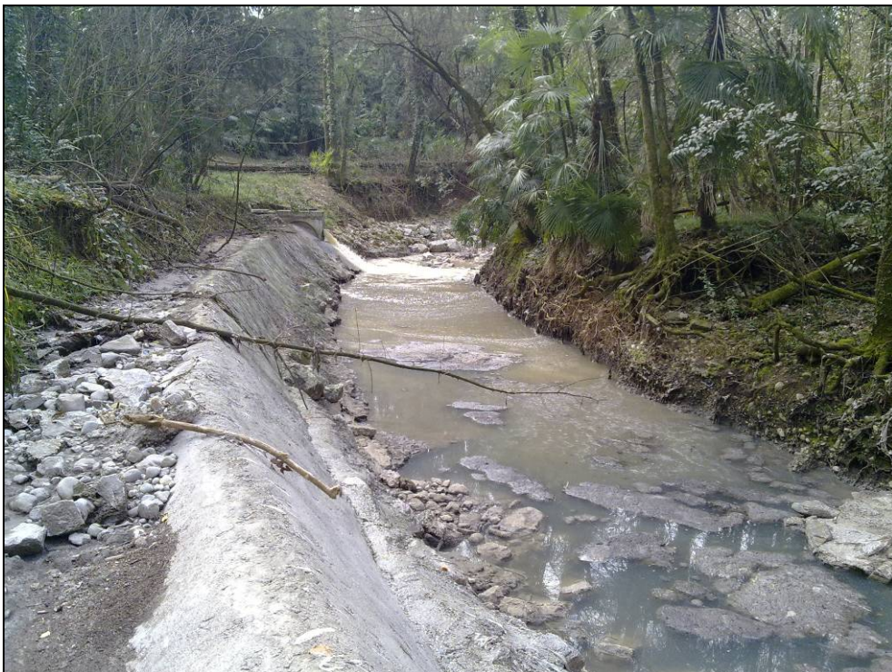
FOTO 16 il torrente Corno a valle del terrapieno di Viale Oriani.
