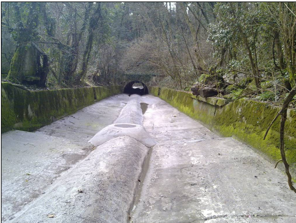
FOTO 14 tratto di torrente Corno canalizzato. In lontananza il terrapieno di Viale Oriani.
