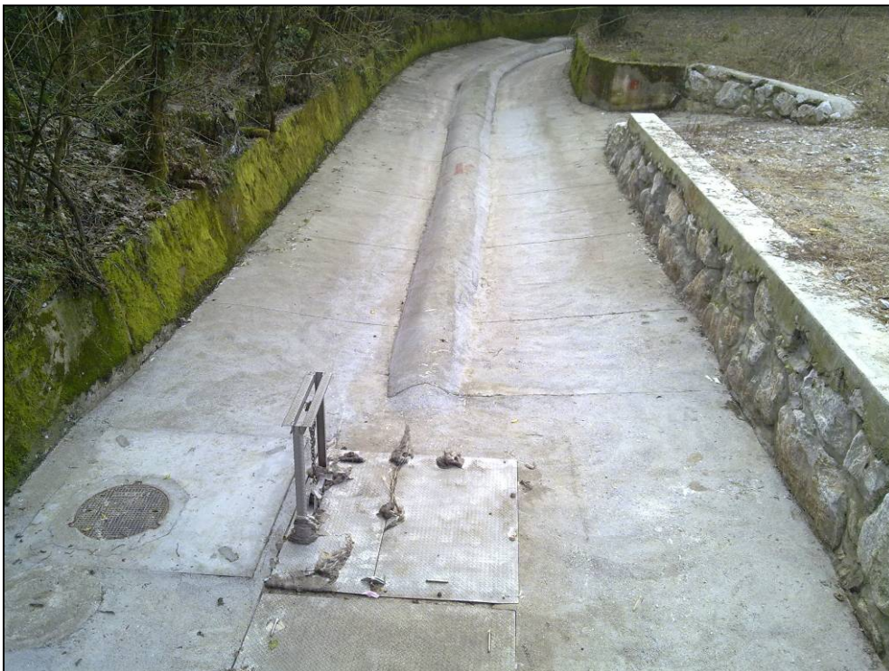
FOTO 12 il torrente Corno canalizzato nel tratto a cielo aperto.
