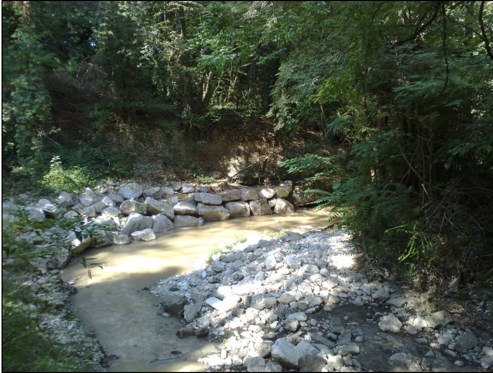
FOTO 17 precaria sistemazione spondale con massi a valle del terrapieno di Viale Oriani.
