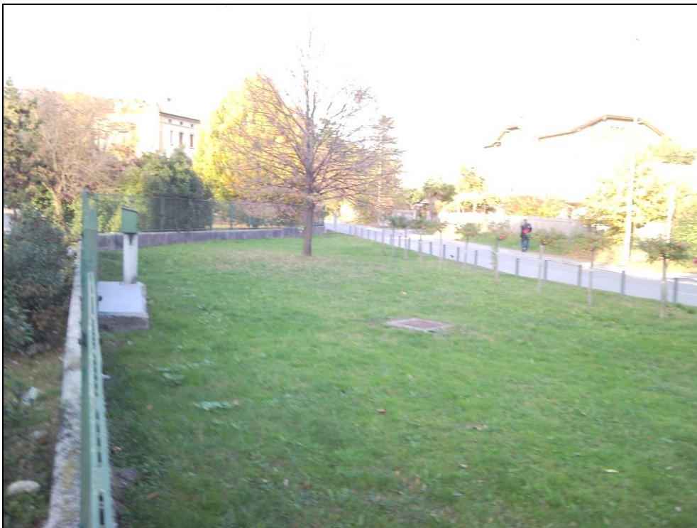
FOTO 4 confine italo-sloveno. Il manufatto ai piedi del muretto individua l'ingresso del torrente Corno nel territorio italiano. Il Corno in questo tratto scorre in sotterraneo.
