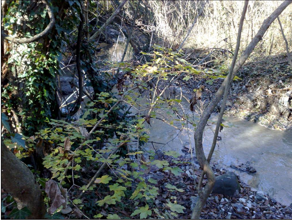
FOTO 49 il torrente Corno in prossimità del terrapieno di Viale Cristoforo Colombo.
