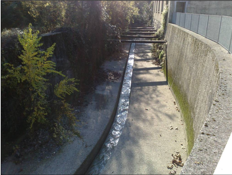
FOTO 55 il torrente Corno canalizzato a fianco dell'industria a valle di viale Cristoforo Colombo.
