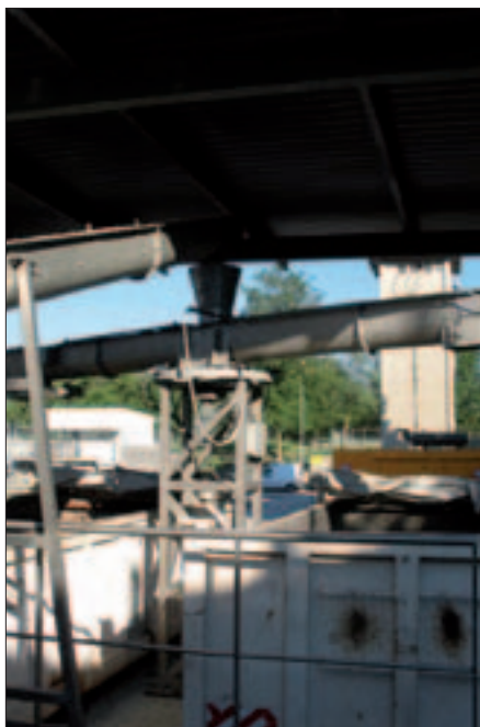
Slika 5.5 Dehidracija blata na ČN Gorizia, Irisacqua.
