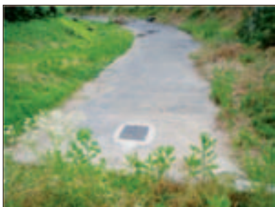
Fig. 3.2: Il torrente Corno in Italia presso il confine.
