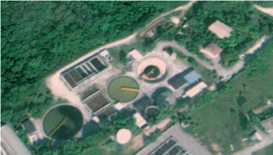
Fig.5.2 L'impianto di depurazione di Irisacqua di Gorizia.
