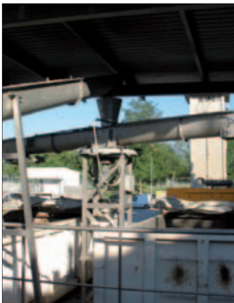
Fig.5.5 disidratazione dei fanghi sul impianto di depurazione Irisacqua di Gorizia.
